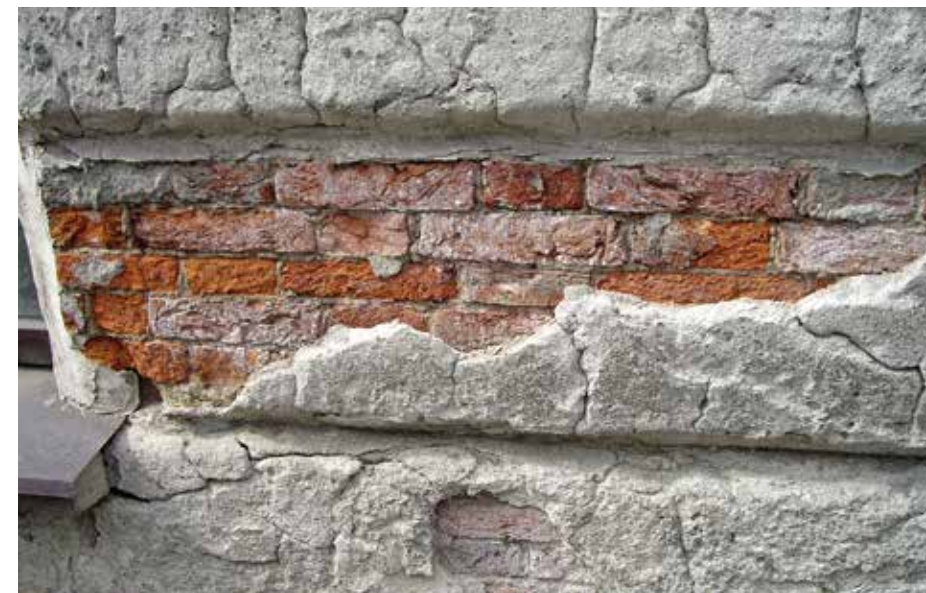
Рис. 1. Южный пакауз Биржи (1826–1832 гг.), г. Санкт-Петербург. Сохранившаяся под известковой штукатуркой кирпичная кладка
