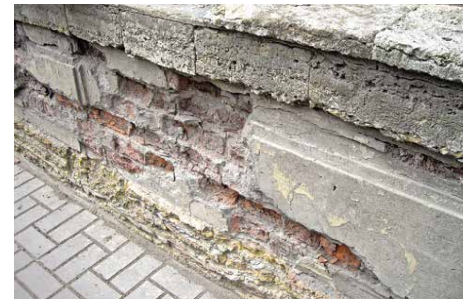
Рис. 2. Цоколь МКД (вторая половина XX в.). Деструкция кирпичной кладки под цементным штукатурным раствором
