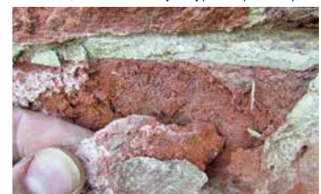
Рис. 2. Цоколь МКД (вторая половина XX в.). Деструкция кирпичной кладки под цементным штукатурным раствором
