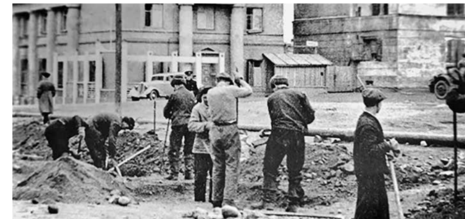
Восстановительные работы в Мурманске. 1944 г. Фото К. Моисеева. Архив С. Поповой
