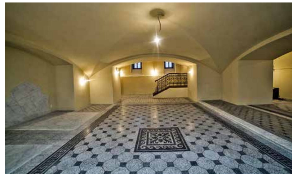
Рис. 4б. Церковь Святого Мученика Иулиана Тарсийского, г. Пушкин. Мозаично-бетонный пол, воссозданный с применением напольной плитки «Рунит Терраццо»
