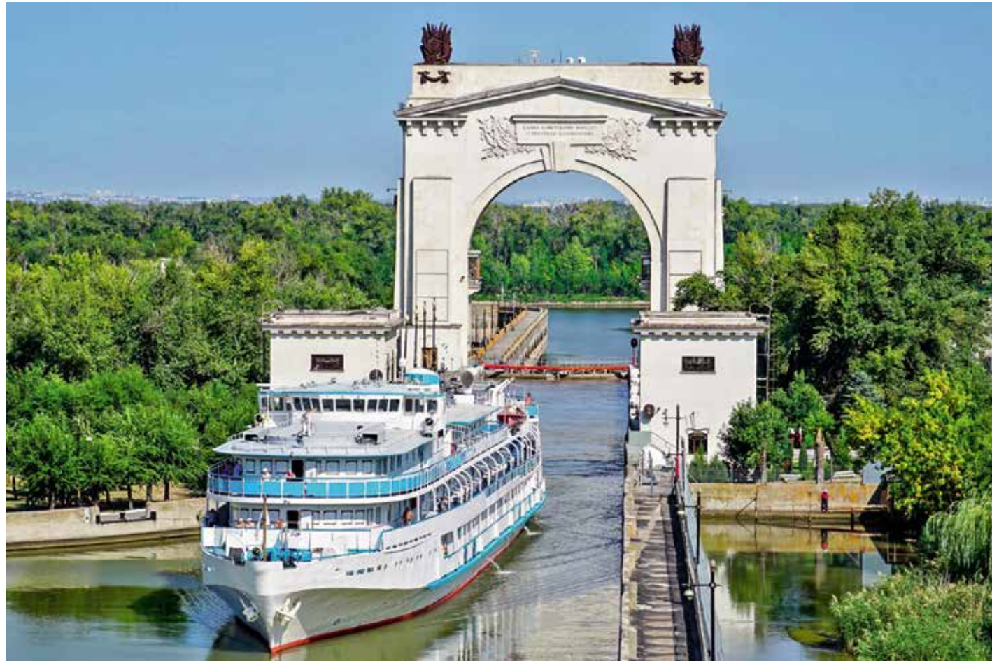
Рис. 3. Шлюз № 1 Волго-Донского канала с отделкой терразитовой штукатуркой (отреставрирован с применением «Рунит Терразитовая» в 2018 г.)
